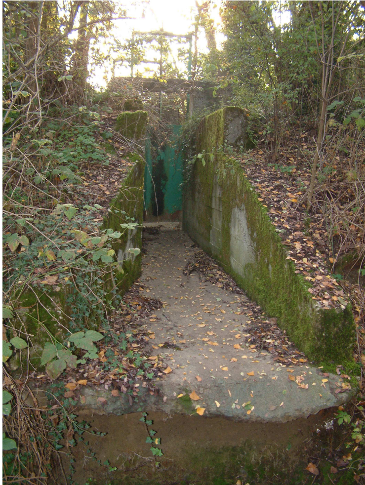
FOTO n. 1 – L'opera di derivazione dal R. Luria e la canaletta in cemento di adduzione idrica verso il bacino n. 3
