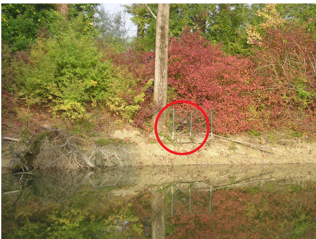
FOTO n. 5 – La tubazione di sfioro (evidenziata nel cerchio rosso) che consente la connessione idrica tra il bacino n. 7 e il bacino n. 11 (foto ripresa dal bacino n. 7).
